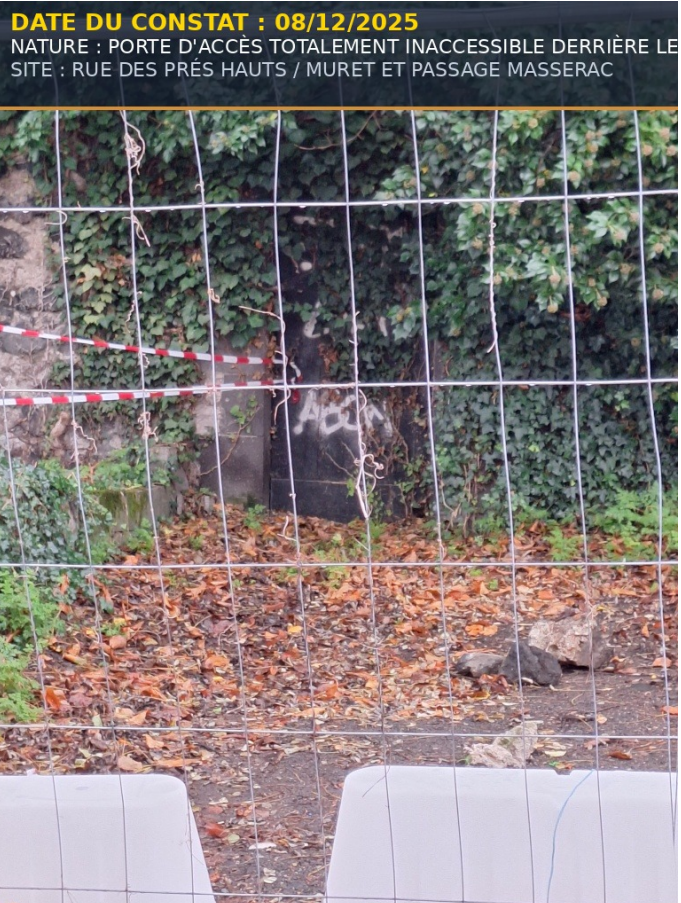
FIGURE 9 Porte d'accès totalement inaccessible derrière les grilles de sécurité
