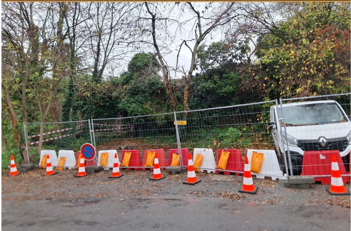
FIGURE 1 Barriérage et condamnation de la Rue des Prés Hauts (Vue rapprochée)
