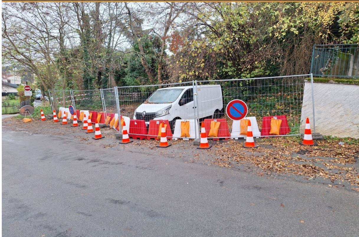
FIGURE 2 Barriérage de la Rue des Prés Hauts empêchant tout passage
